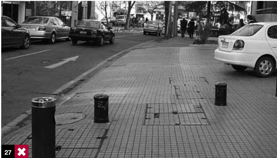
Foto 27: la circulación peatonal se ve afectada por una pendiente transversal excesiva. Santiago, Chile.
